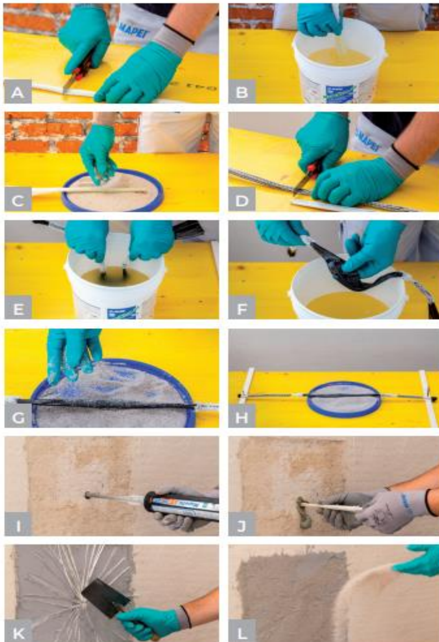
Slika 83 Detalji izvedbe ojačanja sidrima kod jednostranog ojačanja
