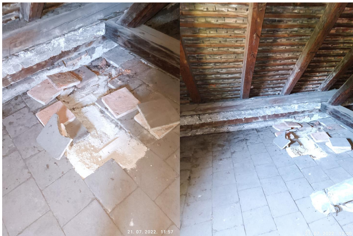
Slika 58: Provedeni istražni radovi međukatne konstrukcije u potkrovlju zgrade 1
