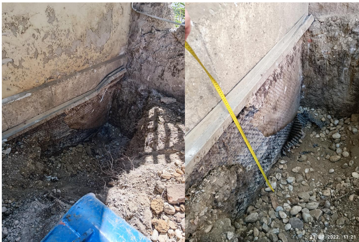
Slika 57: Prikaz provedenih istražnih radova temelja zgrade 1 – Izmjera visine temelja
