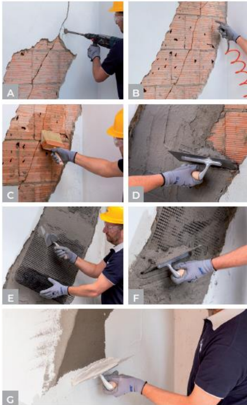
Slika 80 Postupak izvedbe ojačanja FRCM sustavom - praktični dio
