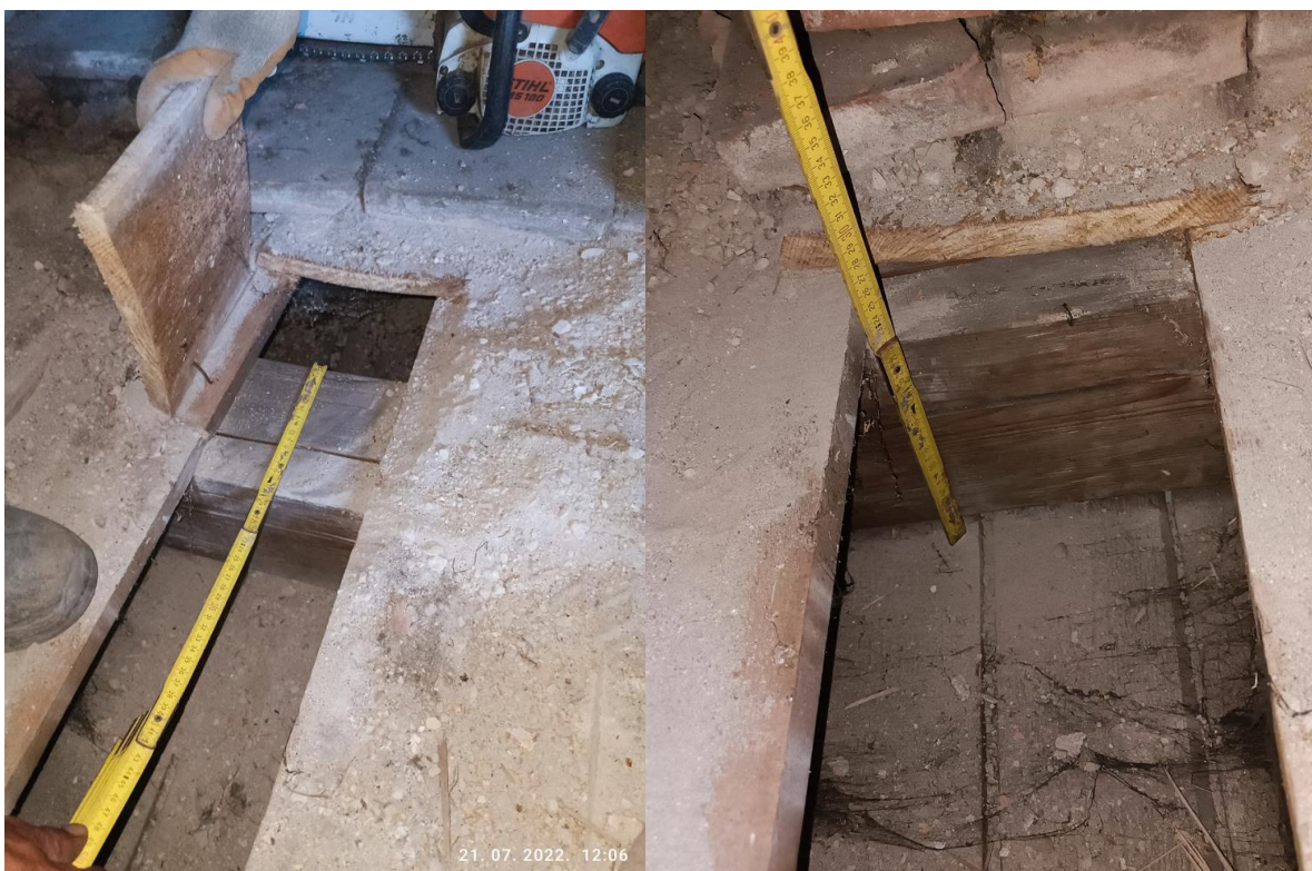
Slika 60: Provedeni istražni radovi međukatne konstrukcije u potkrovlju zgrade 1 – Izmjera dimenzija grednika međukatne konstrukcije
