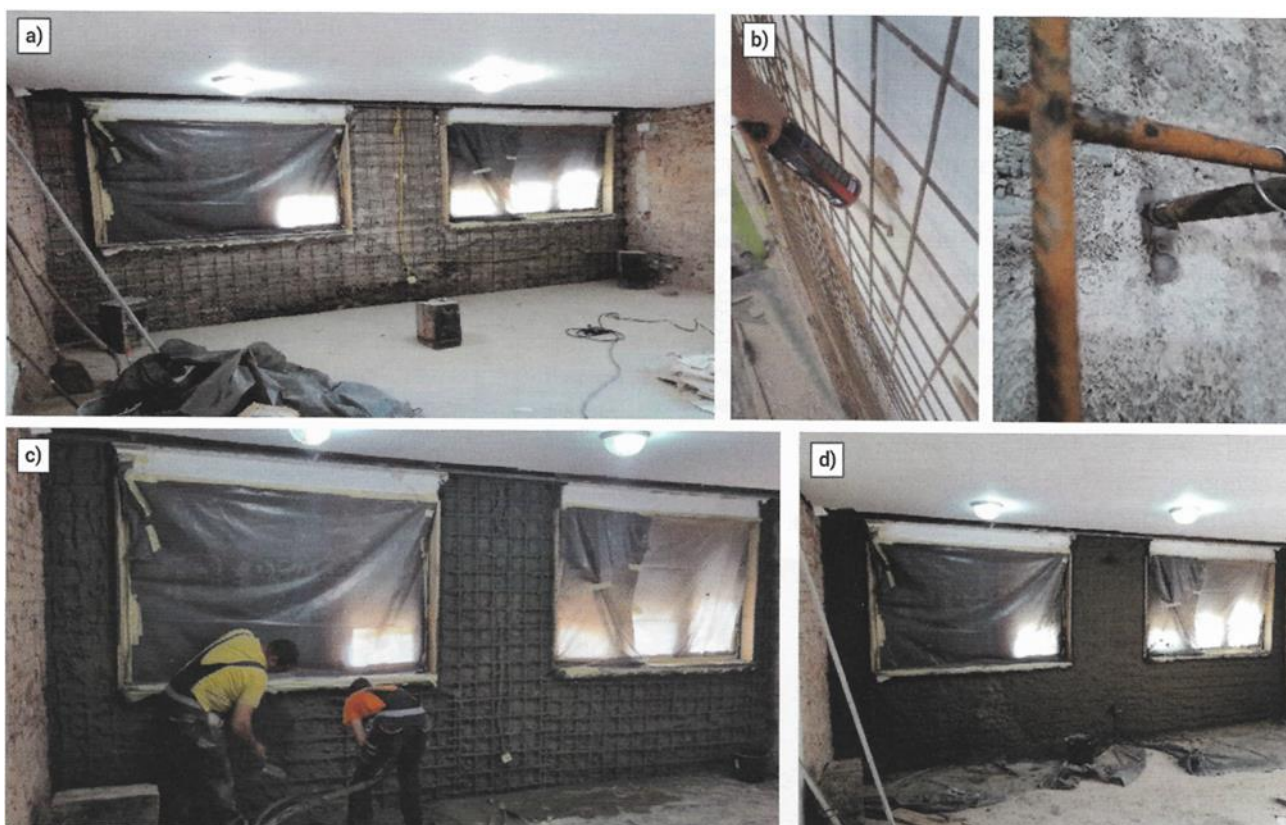
Slika 88: Praktični dio izvođenja radova torkretiranja u etapama: a) postavljanja armatura; b) sidrenje i povezivanje Q mrežom; c) prvi sloj torkreta; d) drugi sloj torkreta.
