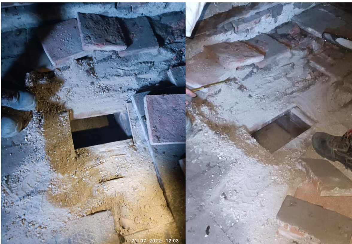
Slika 59: Provedeni istražni radovi međukatne konstrukcije u potkrovlju zgrade 1
