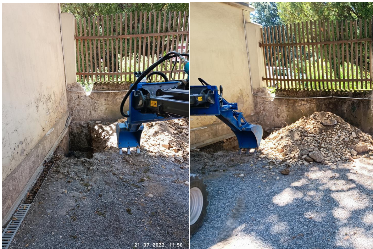
Slika 56: Prikaz provedenih istražnih radova temelja zgrade 1
