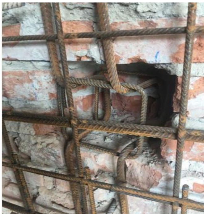
Slika 87: Način postavljanja posmičnih trnova - primjer s gradilišta
