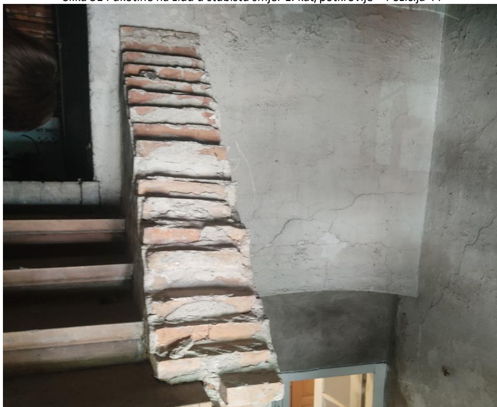
Slika 52 Uklonjeni dio zida u stubištu smjer 1. kat/potkrovlje – Pozicija 45
