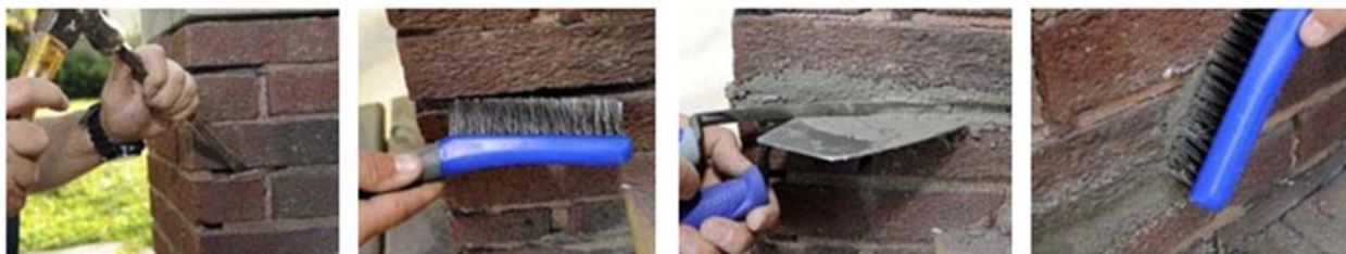
Slika 78: Postupak sanacije i izvedbe
